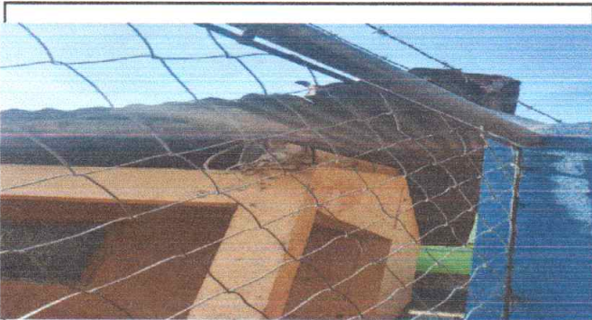
Foto 3: Escuela No. 2 Sustitución de láminas
