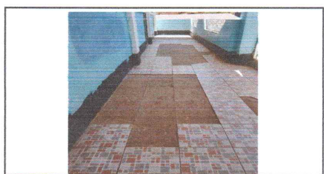
Foto 6: Escuela 1 No. Sustitución de Piso
